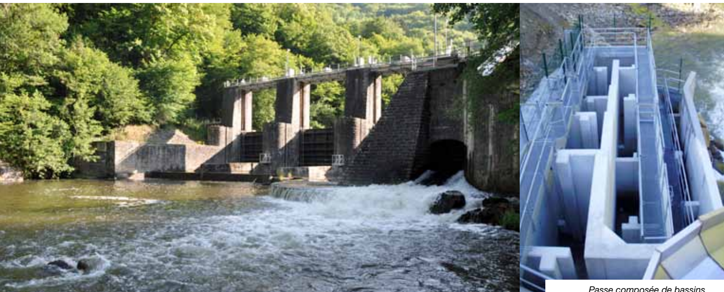
Passé composée de bassins successifs sur site très contraints.
