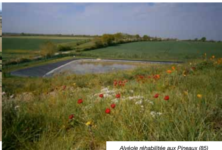
Alvéole réhabilitée aux Pineaux (85)
