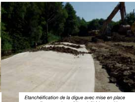
Terrassement de la frayère avec remise en place de la terre végétale
