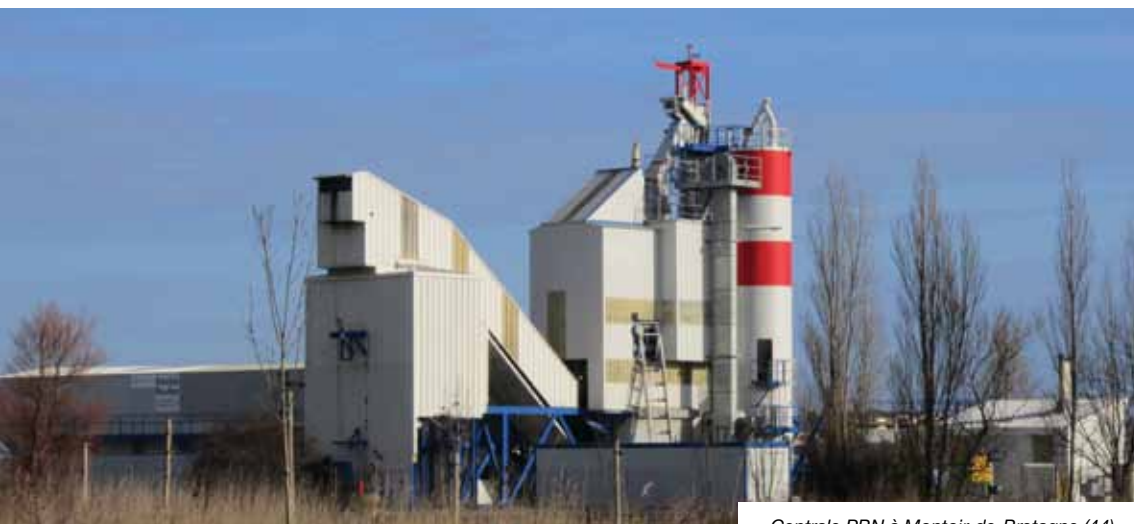
Centrale PBN à Montoir-de-Bretagne (44)
