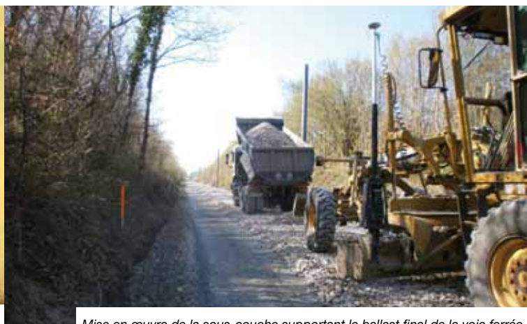
Mise en œuvre de la sous-couche supportant le ballast final de la voie ferrée.
