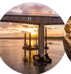
GÉNIE CIVIL TRAVAUX MARITIMES & FLUVIAUX
